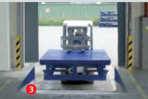
3 Вставить новый перегрузочный мост
