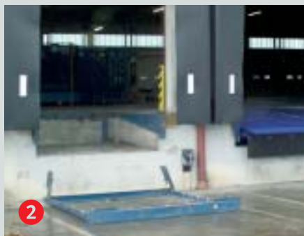
2 Демонтировать старую опорную раму
