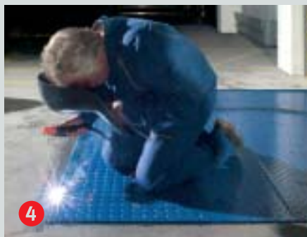
4 Приварить к уголкам по краям – готово!
