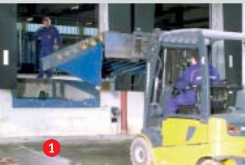
1 Демонтировать старый перегрузочный мост
